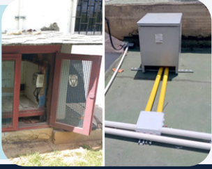
Cambio de Transformador de Gerencia y Canalizaciones Eléctricas
