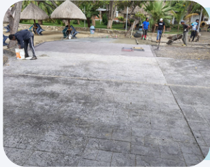
Construcción de pisos estampados
