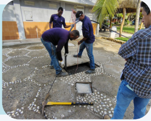
Limpieza de Tanquillas de Aguas Servidas
