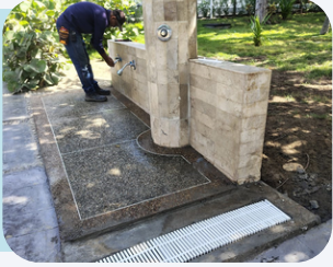
Cambio de Rejillas y Piezas de Duchas de Playa A y B
