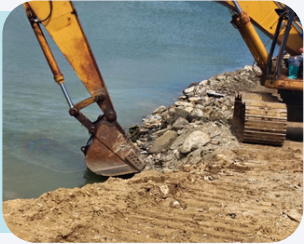
Mejoras en la Pared Interna del Espigón, con uso de Yumbo
