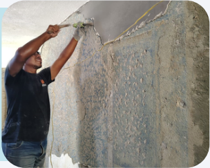
Reparación de Frisos en paredes de Playa B
