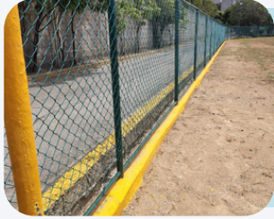
Reparación de Cerca del Estadio de Softball
