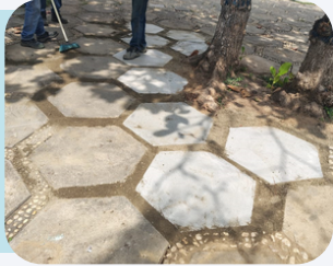
Sustitución de Losas de Concreto en Caminerías
