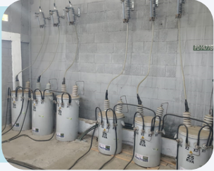
Mantenimiento a Cuarto de Transformadores de área de Varadero
