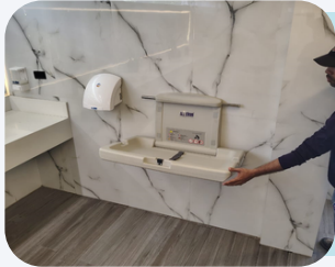
Colocación de Porta Bebe en vestuarios principales
