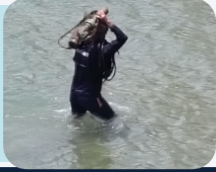
Colocación de tubería y bomba sumergida de servicio, para la planta desalinizadora
