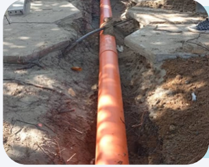
Colocación de Tubería de 6" de drenaje para duchas de Playa A
