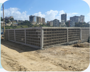
Mejoras en la antigua estación de almacenamiento de combustible de Zona Náutica
