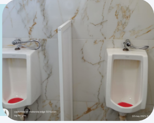
Colocación de accesorios para el baño de Picua
